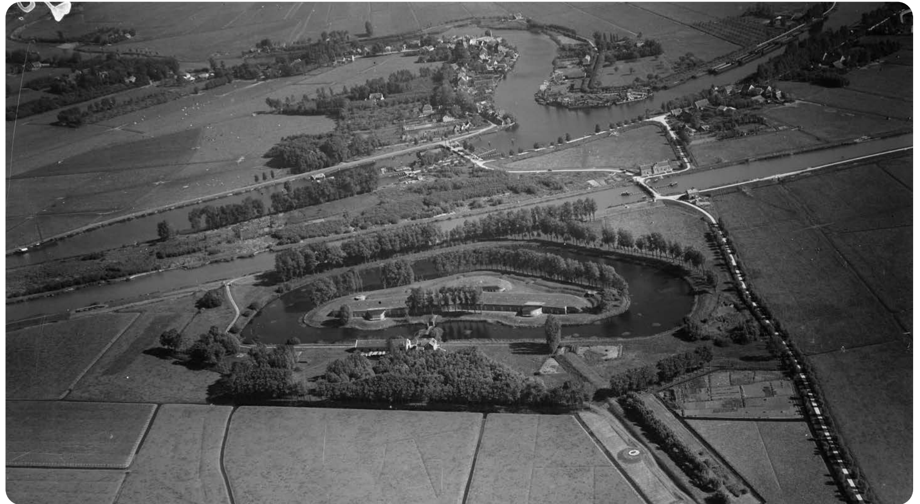
Luchtfoto van Fort bij Nigtevecht met het Amsterdam-Rijn kanaal tussen het fort en Nigtevecht in. Op de achtergrond de Vecht met in de binnebocht Nigtevecht. Bron: Nederlands Instituut voor Militaire Historie, Fototechnische Dienst Luchtvaartafdeeling (1920-1940). Obj. nr. 2011-1032
