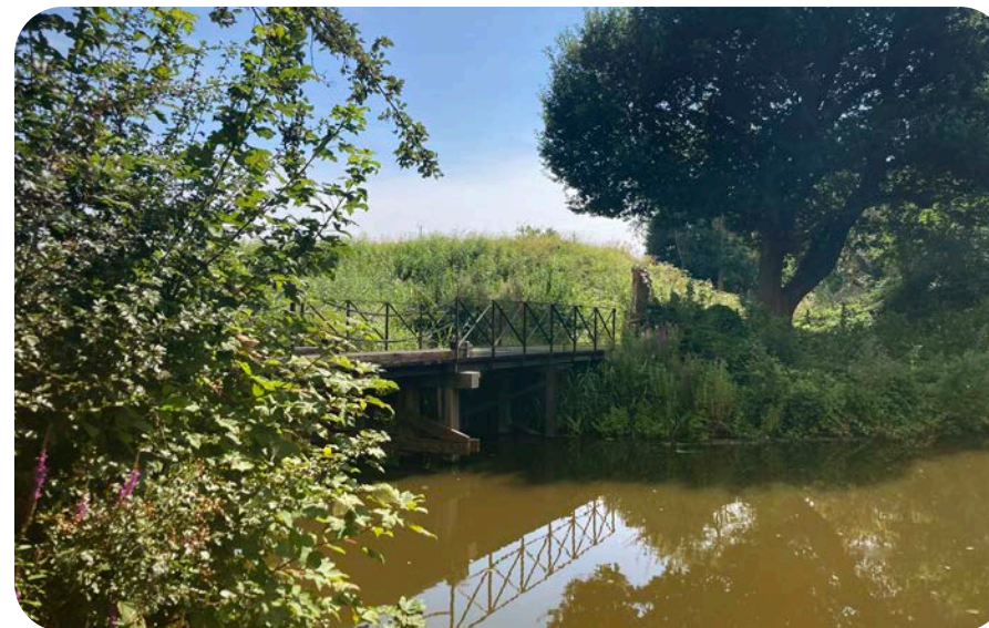
Toegangsbrug en militair groen rondom fort Abcoude
