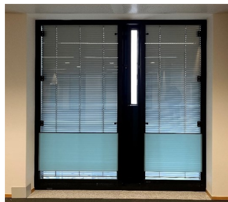
Figuur 4.1: Klimaatraam met gesloten lamellenzonwering
