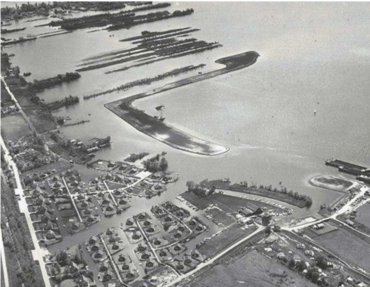
Luchtfoto van de Vinkeveense plas met recreatiewoningen aan de rand, legakkers op de horizon en de aanleg van recreatieiland 1 en 2 (Vinkeveen.nl, 2022)
