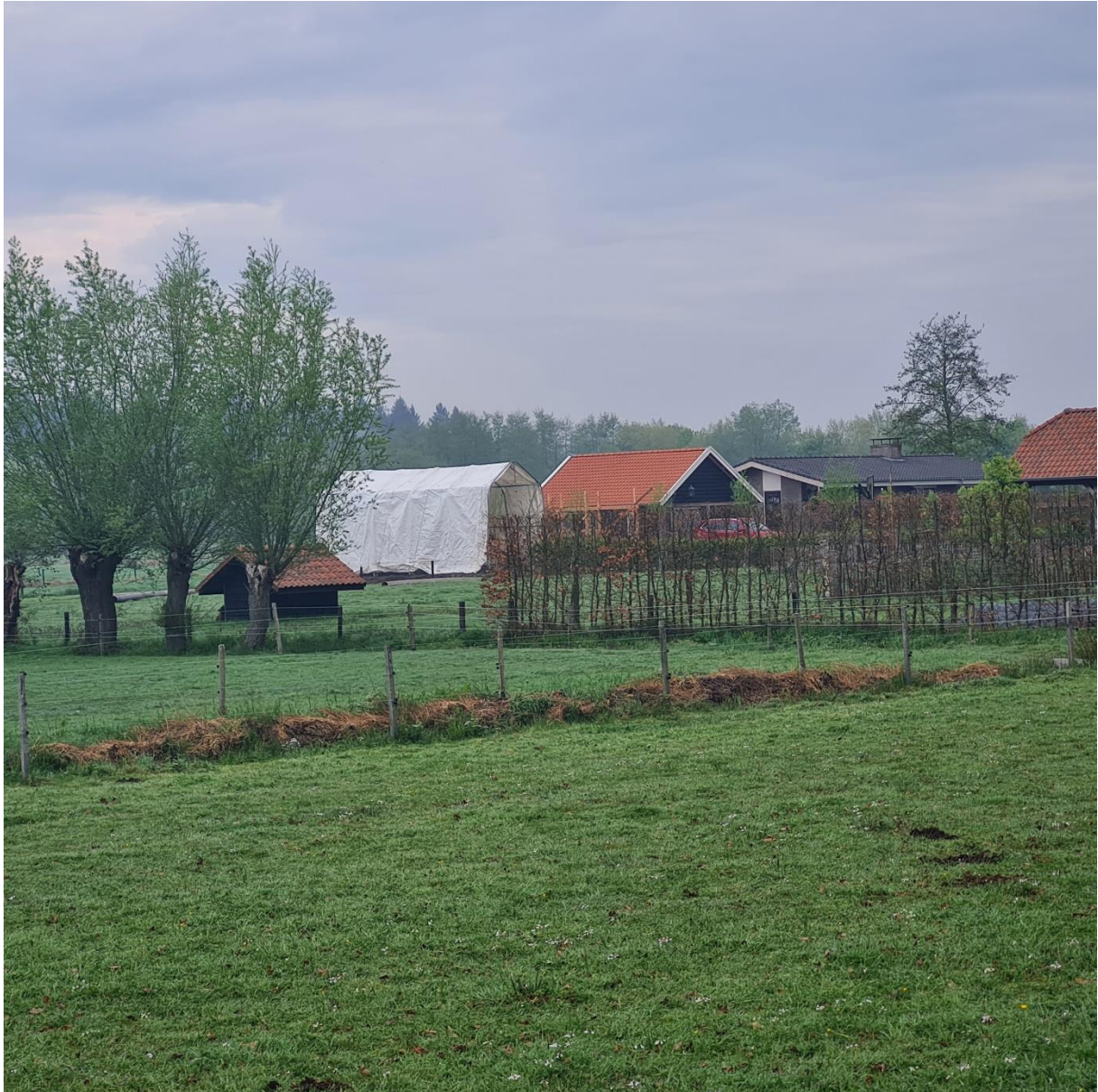
De overkapping van 10m bij 4m en de stal van 2m bij 5m staan vol in het zicht vanaf Wieksloterweg en Dorresteinweg
