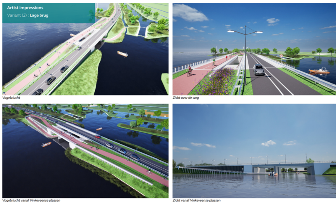
Figuur 2: visualisatie VKA, 2 vaste bruggen met flankerende aarden banen en een hoogte van 4,8 m
