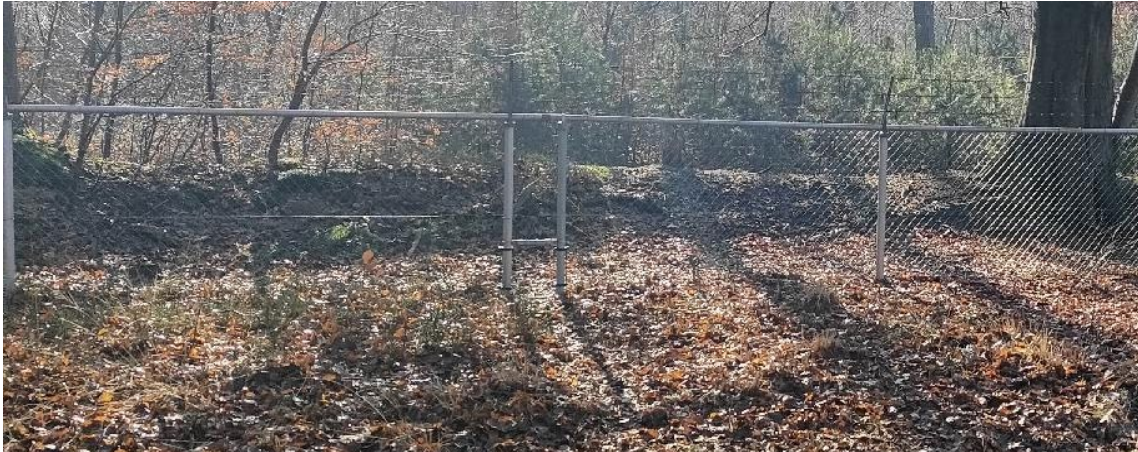
Hekwerk voor ecoduct Boele Staal, met prikkeldraad en 'reeënpoort' van 40 cm hoog.
