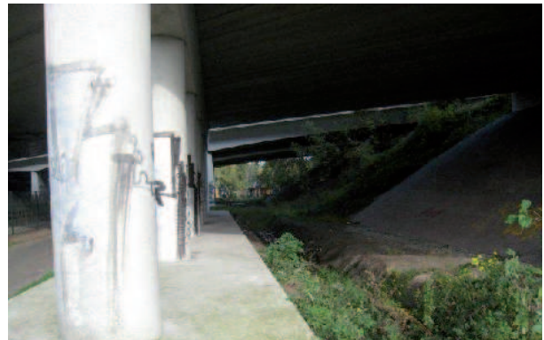
Zone tussen fietspad en landhoofd
