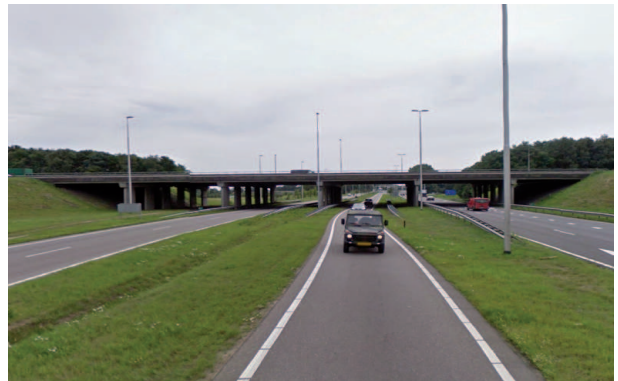
vanaf de N301 richting het zuiden
