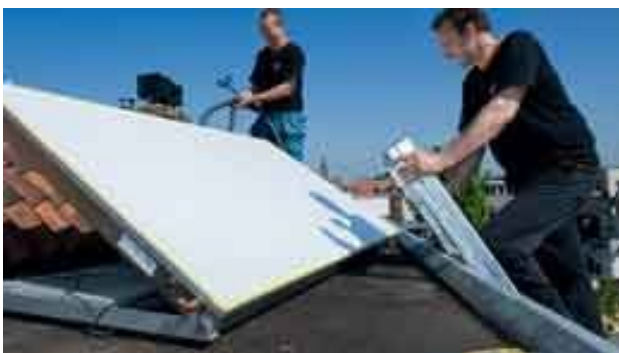
Foto: Installatie van een zonneboiler
