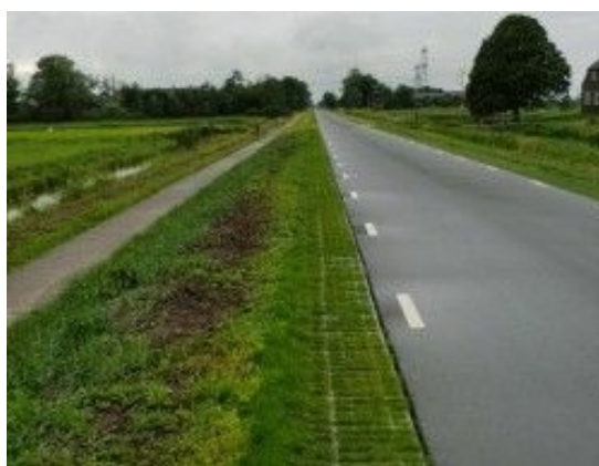
Voorbeeld bermverharding na enige tijd ( www.tonn.nl )
