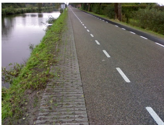
Voorbeeld bermverharding direct na aanleg
