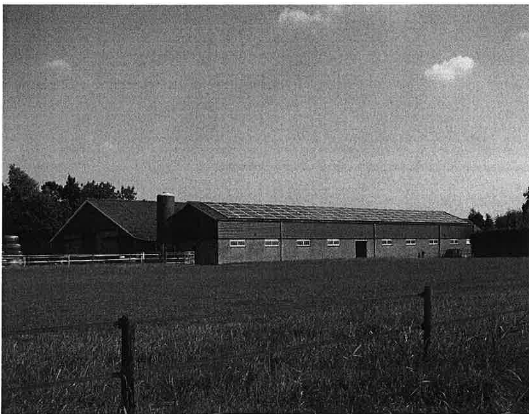
Stal met zonnepanelen in de Lopikerwaard, vrijwel heel dakvlak, goed in het dakvlak geïntegreerd
