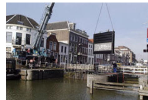
foto 1: Plaatsing schuif Weerdsluis Albert Perrier
