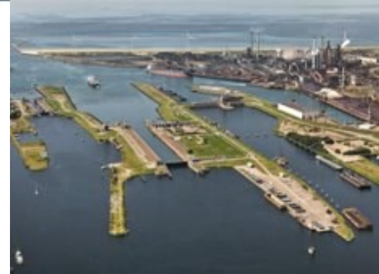
Belangrijkste afvoer: gemaal bij IJmuiden
