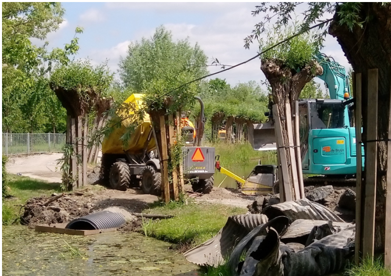
Figuur 20 foto van aanleg nieuwe duiker Vogelzangsekade te Lopik, een maatregel gefinancierd vanuit de Impulsregeling
