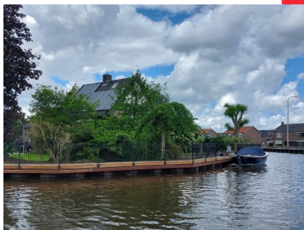
Figuur 8 kadeverbetering Kromme Mijdrecht en Kollensloot afgerond
