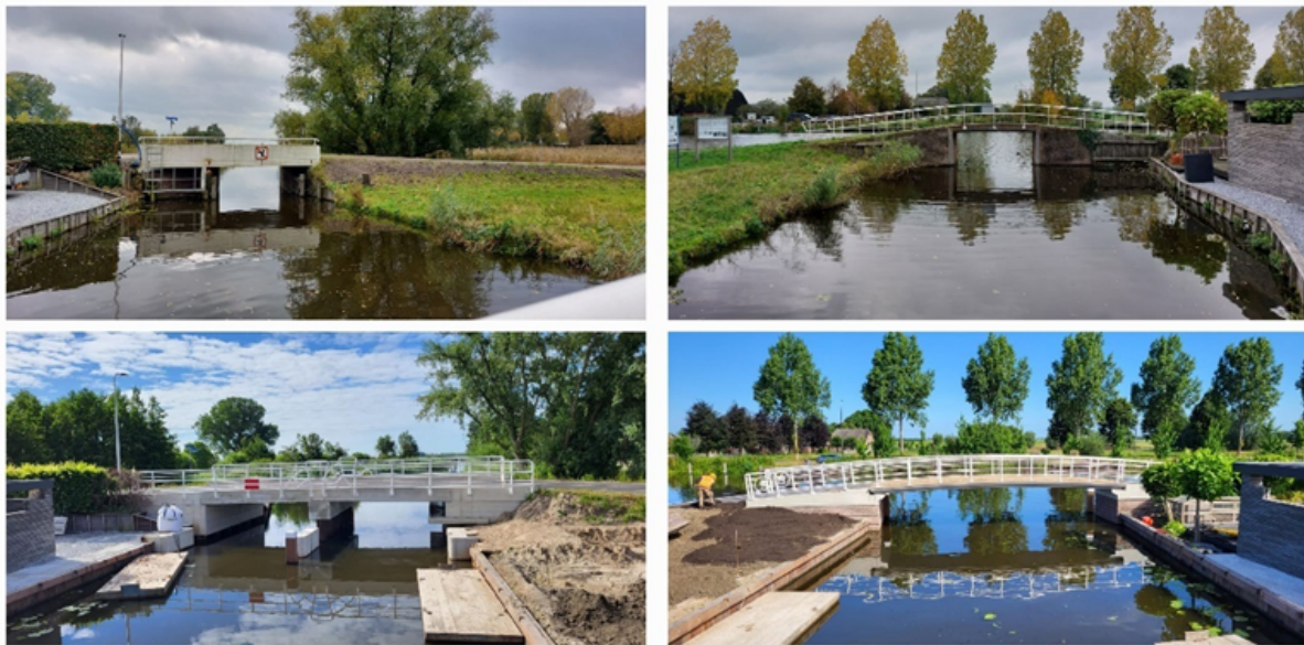
Figuur 11 Enkele voor- en na foto's van Enkele Wiericke. Boven is de oude situatie te zien en onder nieuwe situatie
