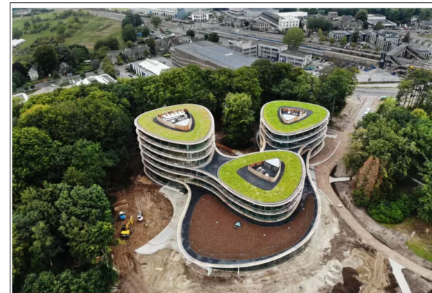
▲ Het hoofdkantoor van de Triodos Bank in bij station Driebergen-Zeist tijdens de bouw in 2019. © William Hoogteyling
