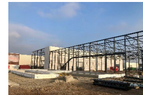
Uitbreiding Inventum Houten – Fabricage duurzame warmtepompen/ boilers
