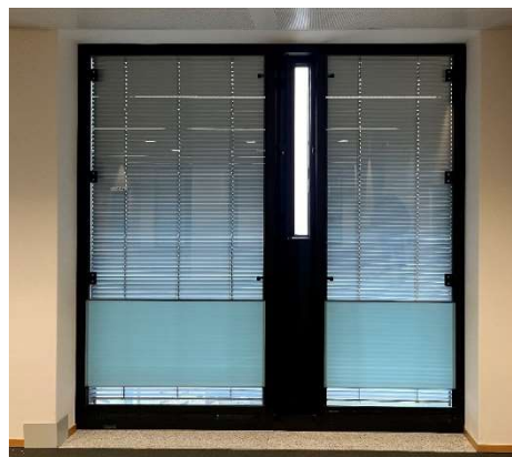
Figuur 21. Klimaatraam met gesloten lamellenzonwering
