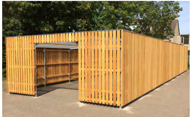
Fietsenstalling met houten schotten
