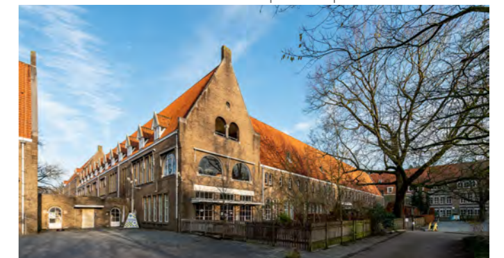
Kopgevel van het kloostergebouw
