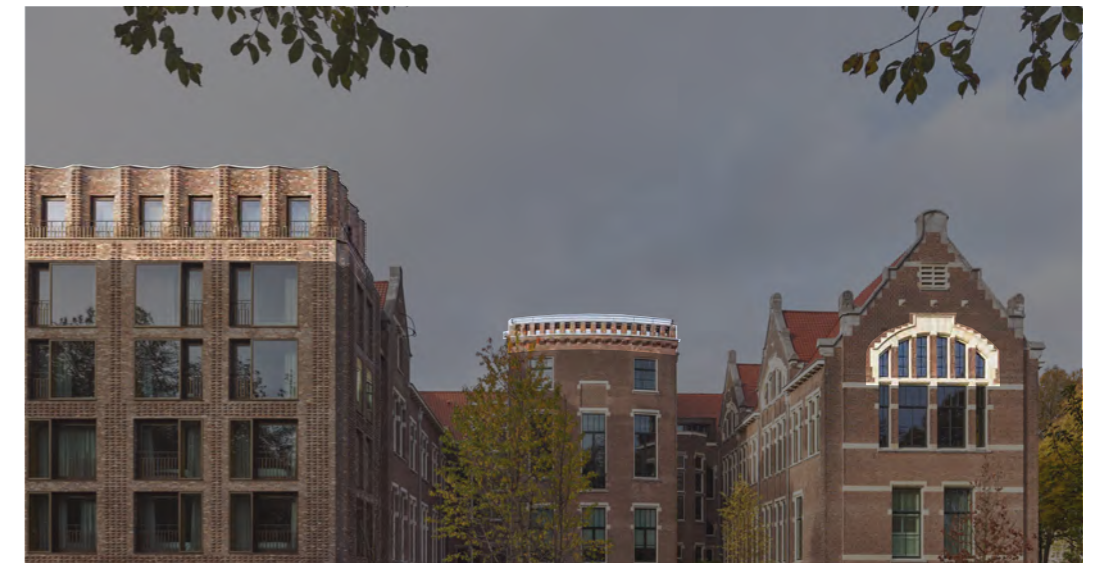
Transformatie 'Pillow Hotel' Amsterdam, Winhov architecten
