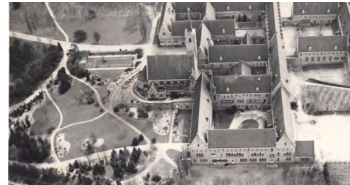
siertuin direct na aanleg
