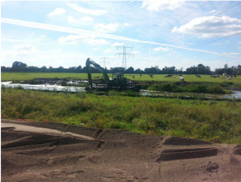
Figuur 2: Herstelwerkzaamheden verzakken watergang na voorbelasting
