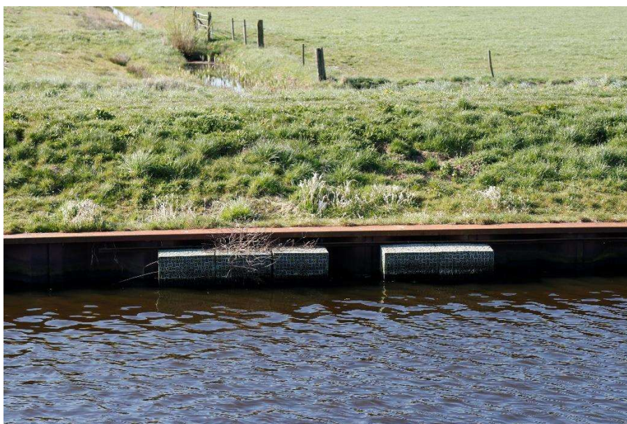
Figuur A.2: korven toegepast langs een testsectie langs De Eem.
