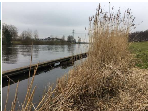
Foto 4 (bestaande situatie damwand)
