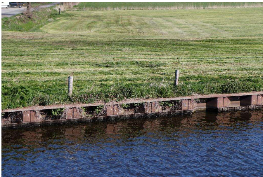
Figuur A.1: toegepaste roosters langs een testsectie langs De Eem.
