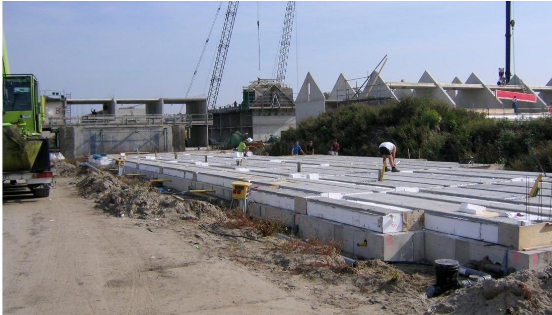
Woningen in aanbouw.
