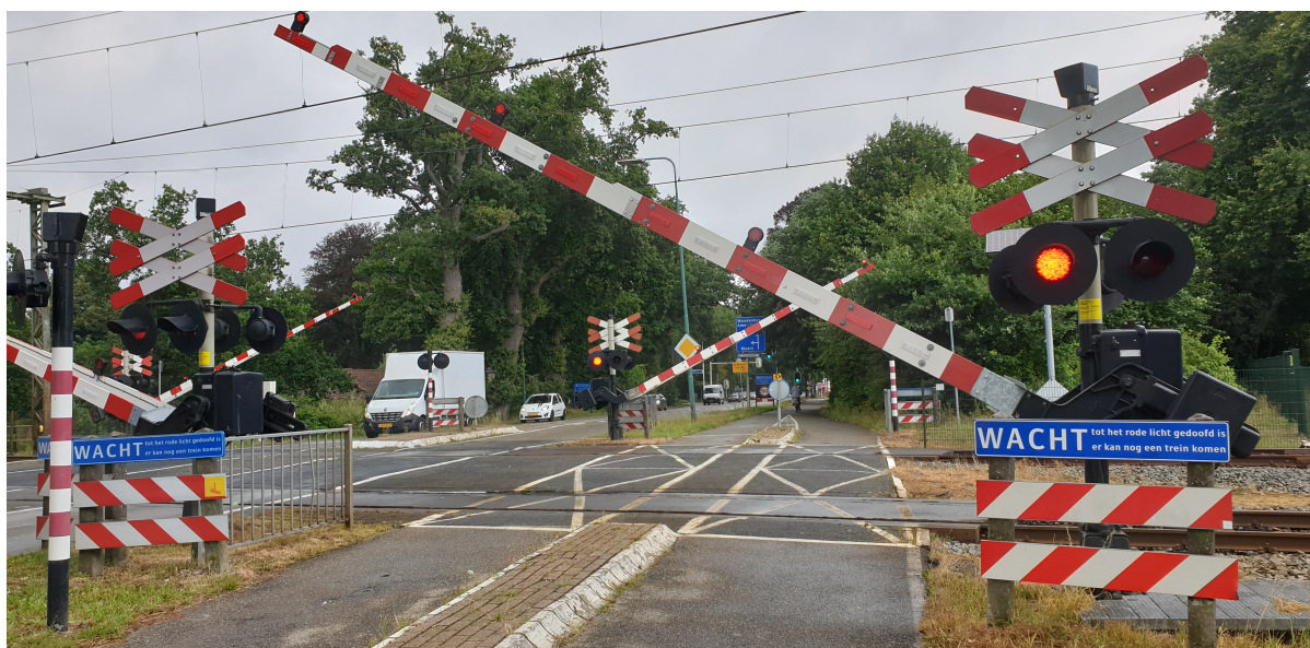
afbeelding 1.1: huidige situatie spoorwegovergang
