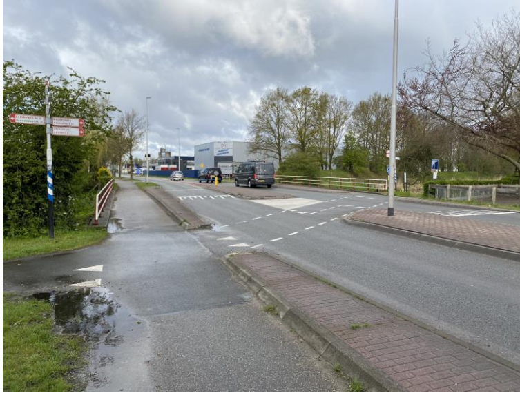
Afbeelding 2.8 Kruisput N224 - Jaagpad, gezien vanuit het oosten
