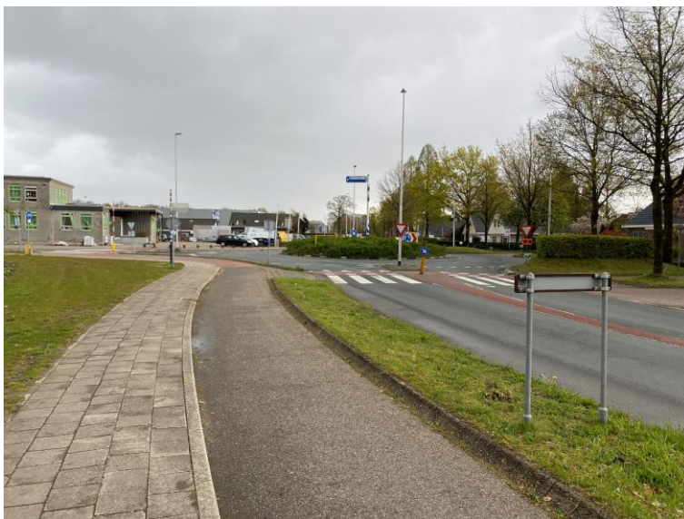
Afbeelding 2.6 Rotonde N224 - Parallelweg, gezien vanuit het westen
