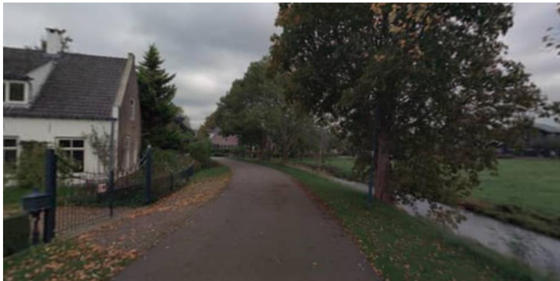
Figuur B6.2: Sluisje aan de zuidzijde van Vreeland
