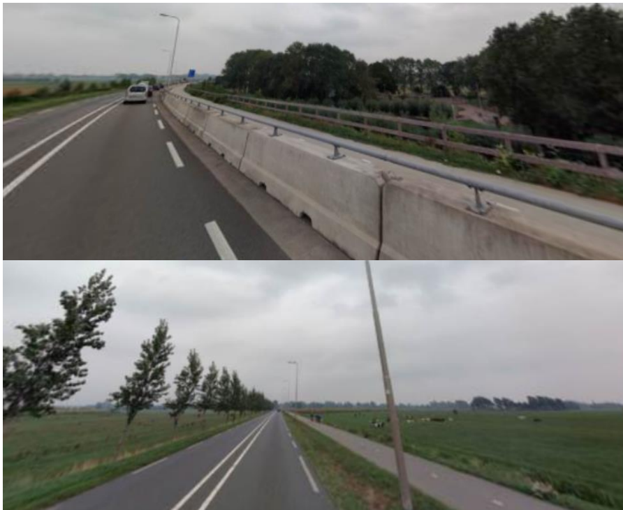
Figuur 3.4: Fietspad Loenersloot – Vreeland. Boven: Fietspad op de brug over het ARK, gescheiden van de rijbaan met barriers. Onder: Fietspad tussen N402 (Loenen) en Vreeland
