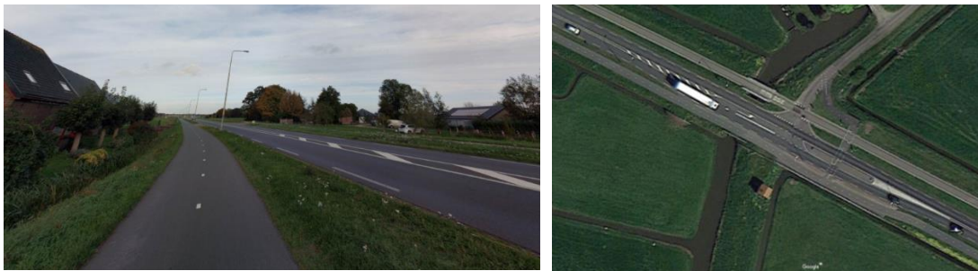
Figuur 3.1: Fietspad langs N201 ten westen van en ter hoogte van de Middenweg
