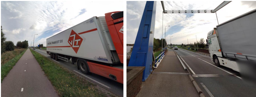
Figuur 3.2: Fietspad dicht langs de N201 ten westen van de A2 en ter hoogte van de Demmeriksebrug
