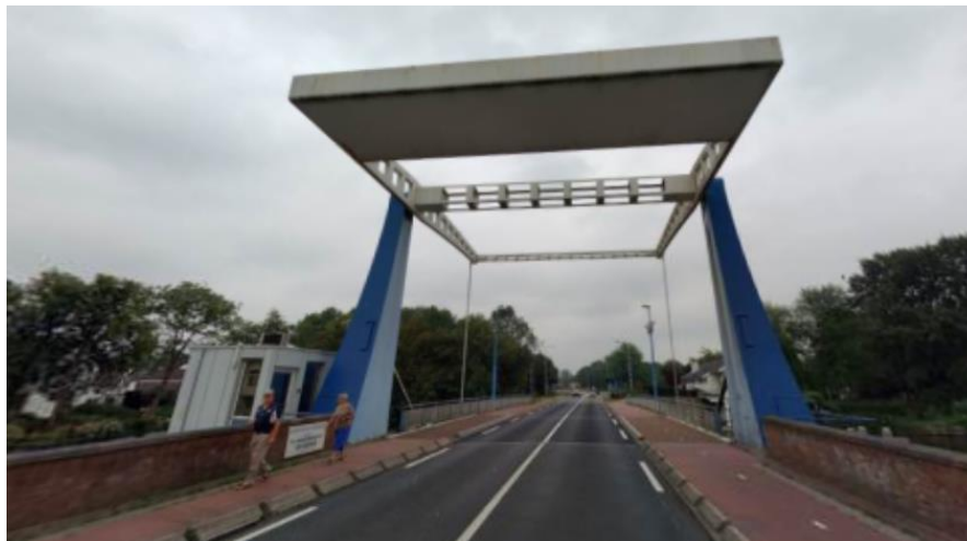
Figuur 3.6: Op de Vechtbrug ligt het fietspad pal naast de N201
