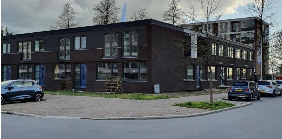
Figuur 1.1 Huidige situatie (11 april 2021) Kluswoningen Kanaleneiland
