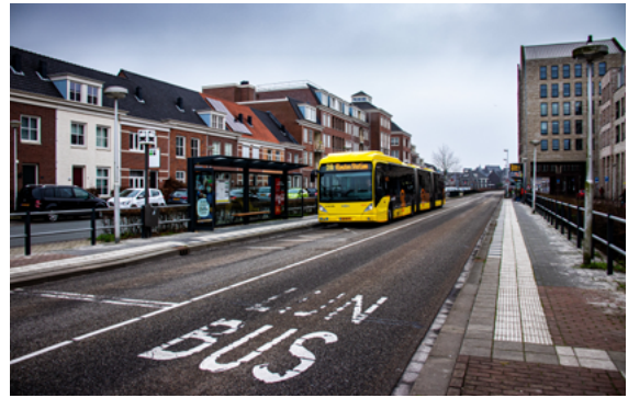
HOV-baan richting station Vleuten
