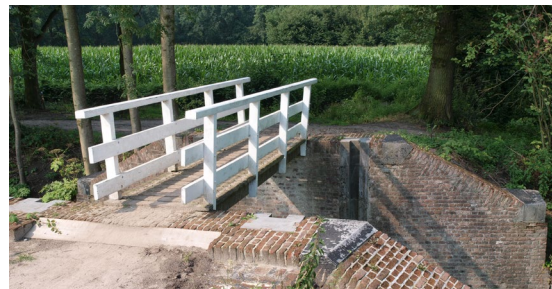
Doorlaatsluis om inundatiewater vast te houden
