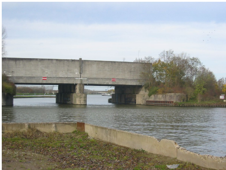
Plofsluis in het Amsterdam-Rijnkanaal
