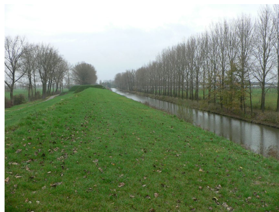
Inundatiekanaal bij Honswijk
