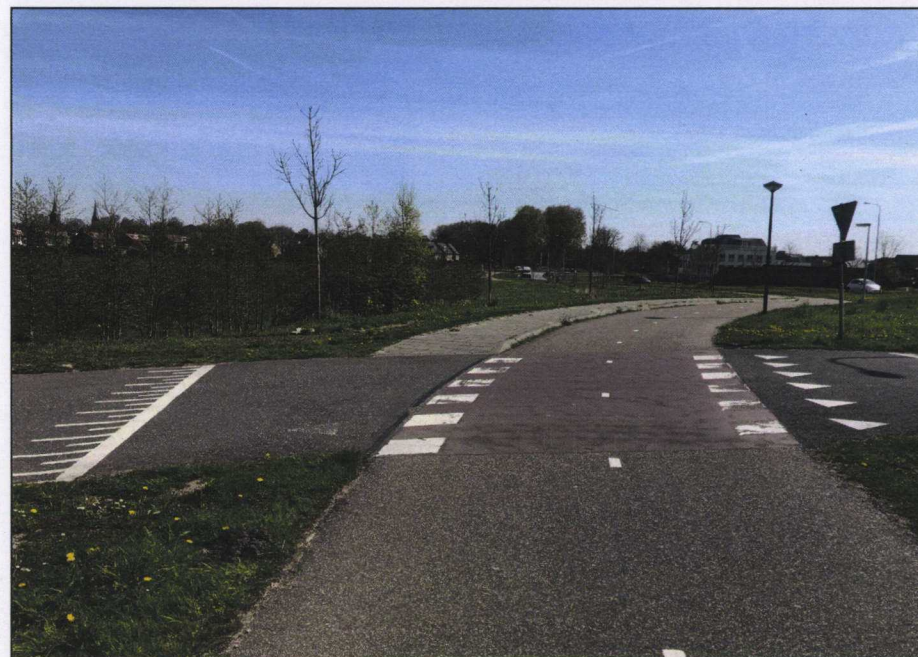
Fietspad vanuit bushalte/carpoolplaats richting Abcoude
