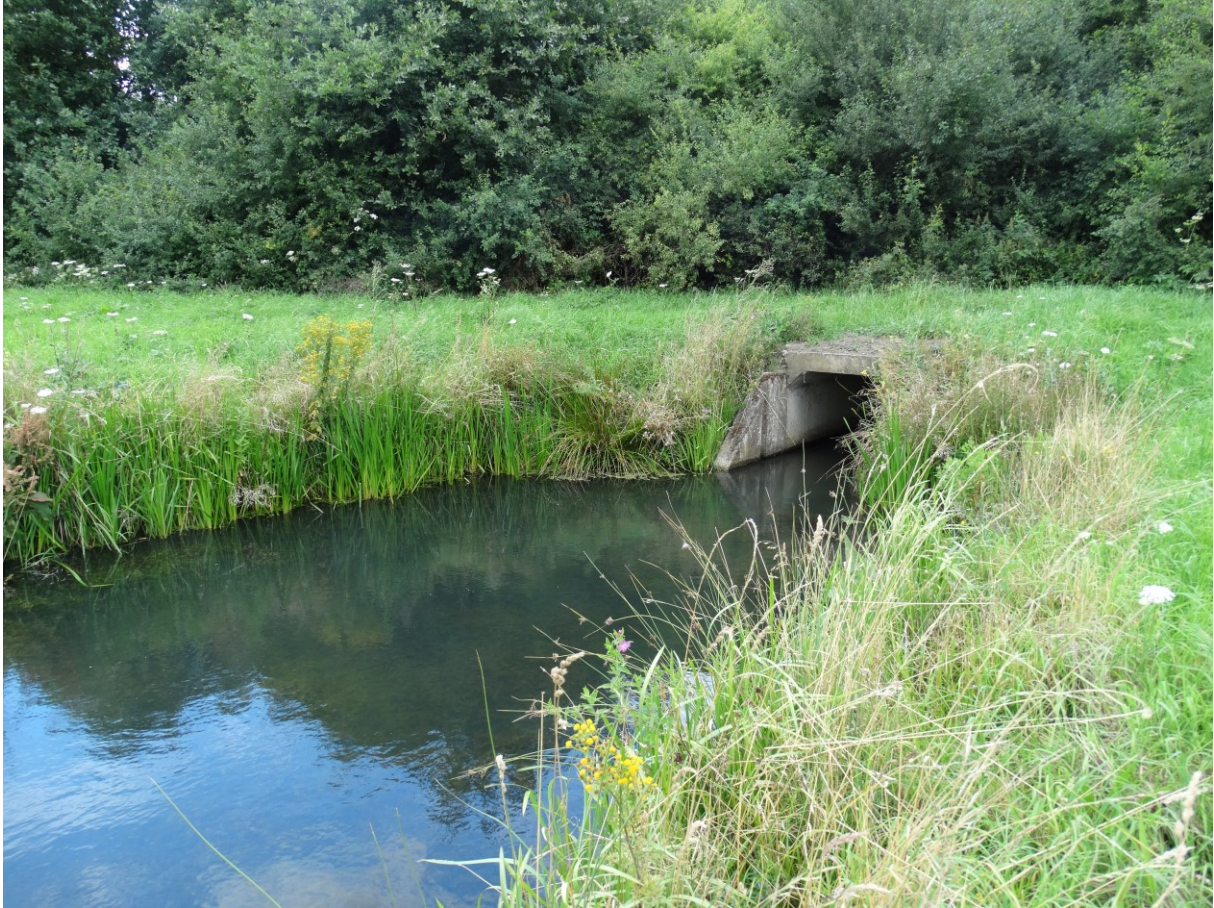
Figuur 5. Duiker aan de noordwestzijde van het onderzoeksgebied. Foto: Ron Beenen, 28 juli 2020.
