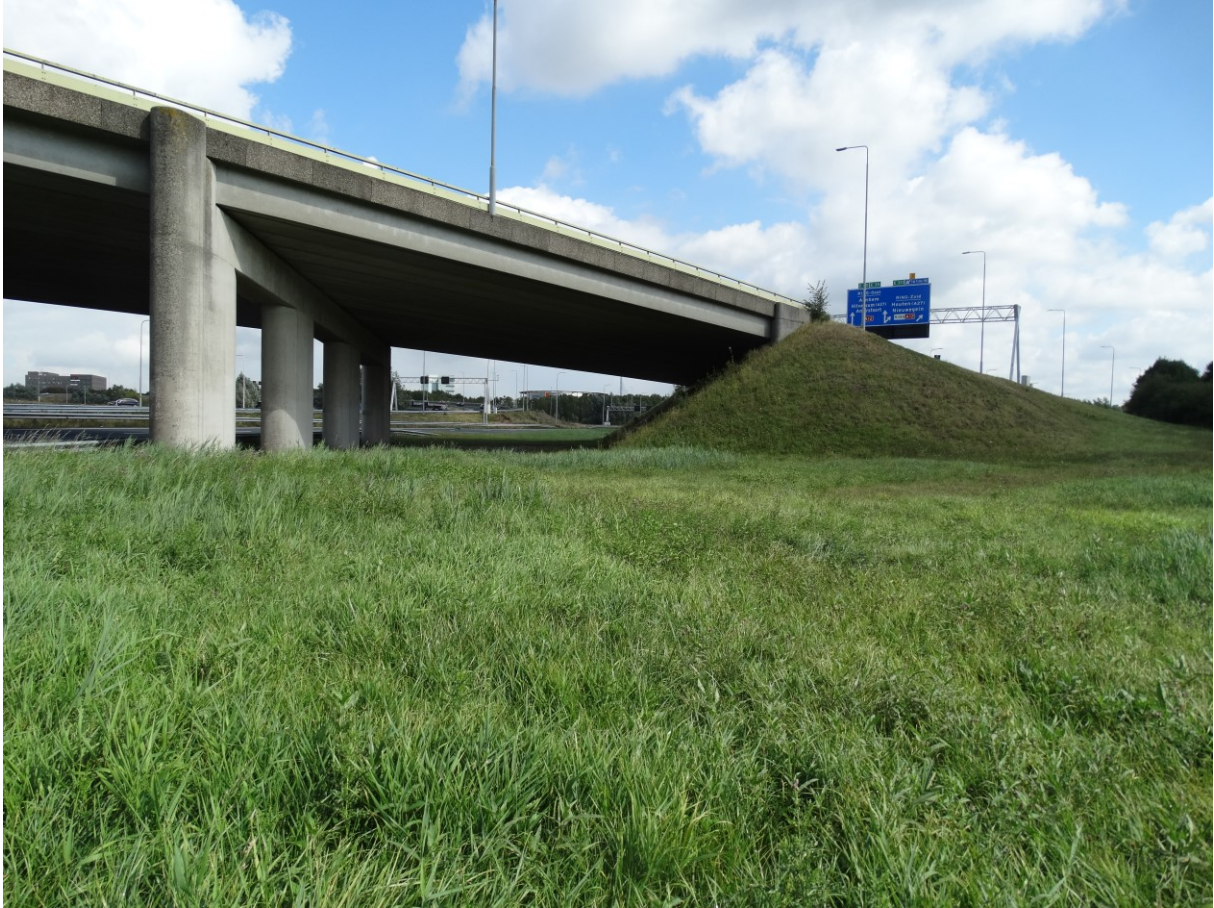
Figuur 6. Onderdoorgang langs rijbaan. Hier is een brede strook onder de rijbaan die twee grazige terreinen verbindt. Foto: Ron Beenen, 28 augustus 2020.
